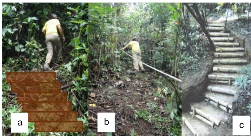
Figura 4: (a) Esquemática de intervenção no Ponto 9 e (b) subida íngreme a partir do Ponto 10 da Trilha da Mata (Rancho Sol Dourado, Nova Friburgo-RJ). (c) Trilha com traçado em zigue-zague (RPPN Paiol Maria, São Lourenço da Serra-SP). Fotos: Autoras (2019).
